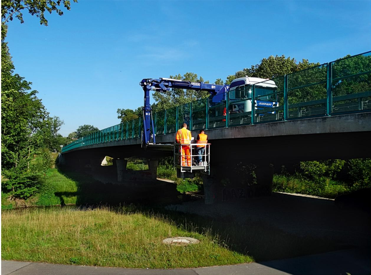
Abbildung 5: Bauwerksprüfung nach DIN 1076
