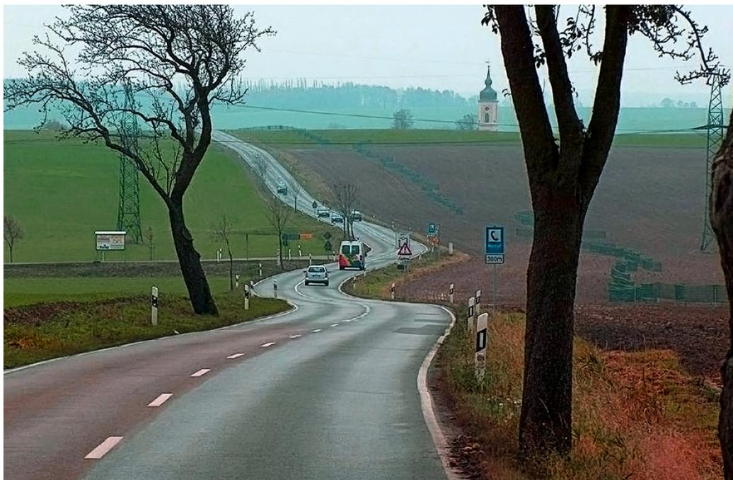
Abbildung 10: S 177 Meißen-Wilsdruff, NK 4956 059 Station 350, Beispiel für eine geländenahe, räumlich schlechte Linienführung
