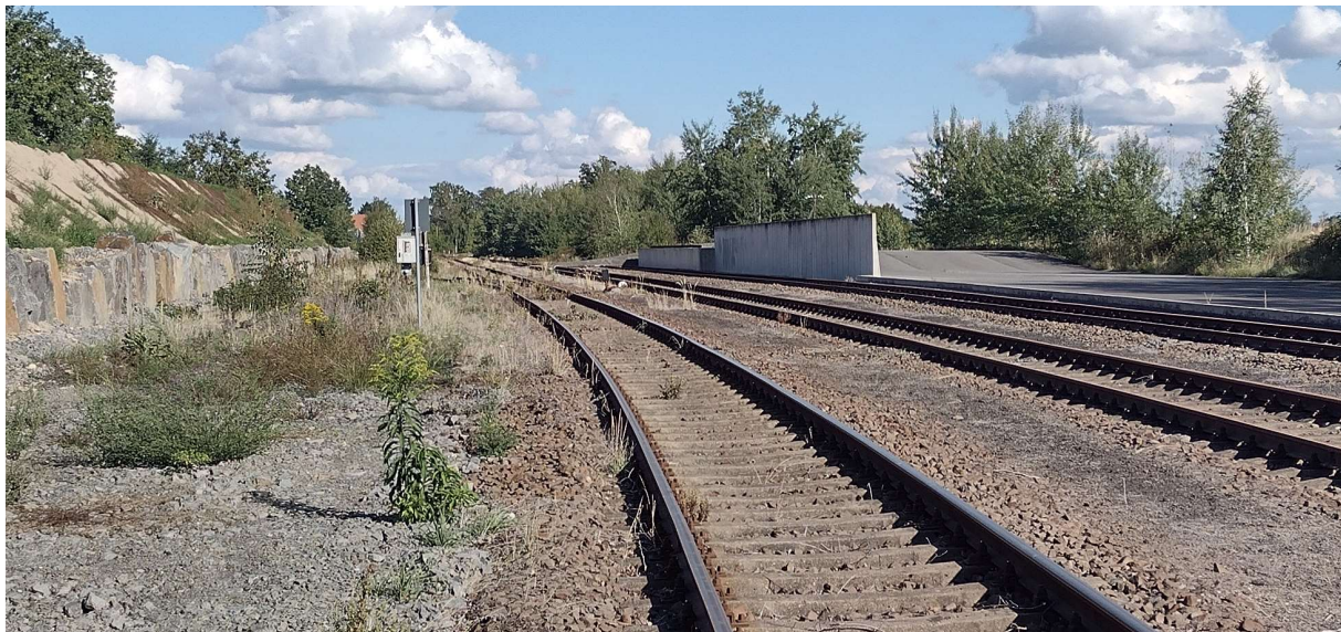
Abbildung 21: Gleisanlagen Altenhain mit Verladeanlage
