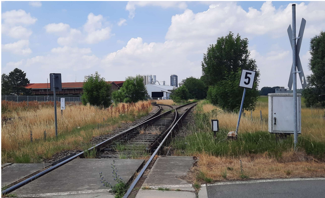
Abbildung 24: Gleisanschluss MOCO Holzverarbeitung
