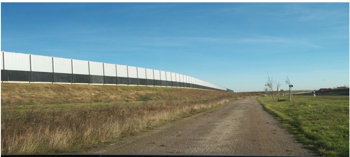
Abb. 19 Lärmschutzwand (Quelle: FLHG)
