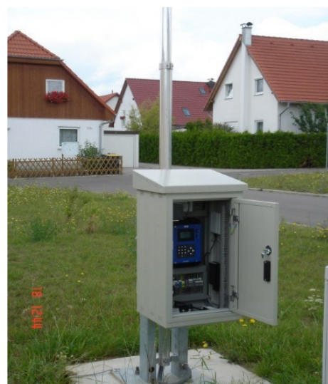
Abb. 2 Stationäre Fluglärmmessstelle (Quelle: FLHG)
