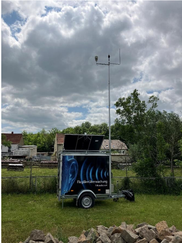
Standort: Bad Dürrenberg / Tollwitz
