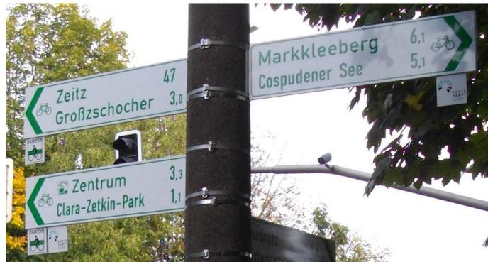
**Bild 14** Tabellenwegweiser mit Rohrschellen an Standardmast befestigt
