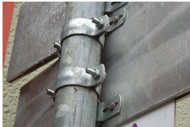
Bei Tabellenwegweisern handelt es sich um Hohlraumprofile. In die hintere Wand des Hohlraumprofils wird ein Loch gebohrt und mit einem Gewinde versehen. Die Schraube kann daher von hinten eingesetzt werden, so dass die Vorderseite unversehrt bleibt
