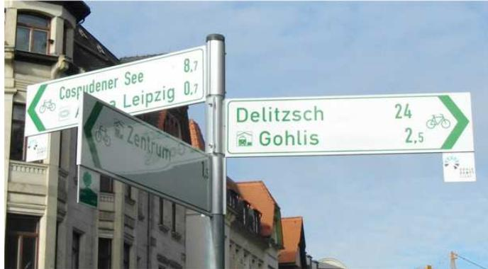
**Bild 13** Pfeilwegweiser mit Stahlbandschellen an Lichtmast befestigt
